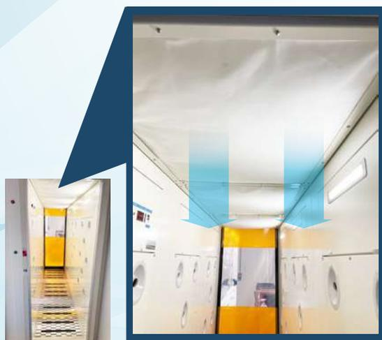
エアシャワーは水平方向にエアジェットを吹き出す為、対面の壁に当たったエアは周囲に拡散します。その時、舞い上がったゴミ・ホコリはいつまでも気流渦に巻かれてなかなか落ちてきません。
